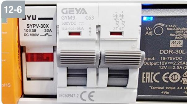
Stellen Sie den Hauptschalter im Sicherungskasten auf die Position „ON“.
